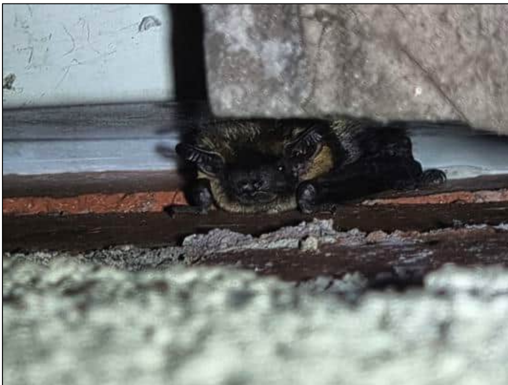
Kuva 18. Pohjanlepakko piileskeli heinäkuussa hormin ja kattorakenteiden välisessä raossa. RK.
